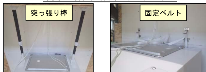
写真5. 各固定器具の取り付け状況
