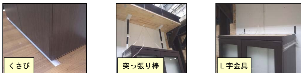
写真4. 各固定器具の取り付け状況
