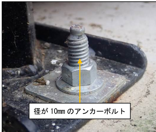
(a) 10mm 径のアンカーボルト 3 本で固定されたもの
